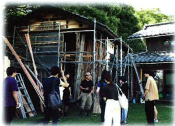
空き家の改修現場で職人さんから聴き取り調査
