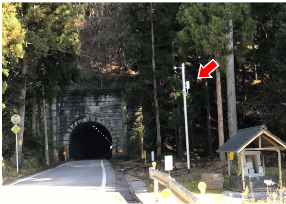
新しく設置された防犯カメラ
