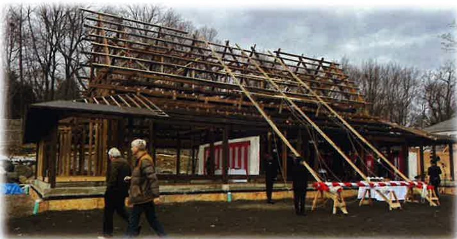
ボストンで再建築中の古民家(R5.12)
