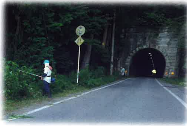
R6.8.11 谷坂隧道付近の除草作業
