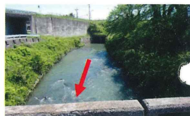
現在のボックスカルバート (下流側)
