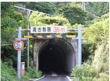
14.柳ヶ瀬トンネル
