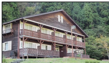
・大見いこいの広場 （レクリエーション施設）
