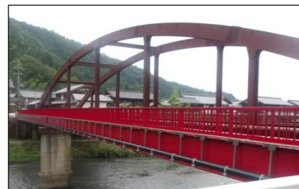
△川合歩道橋修繕（木之本町川合）
