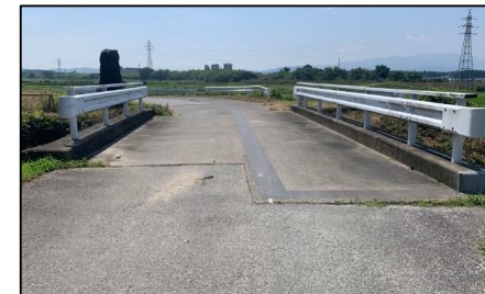
△三谷尻3号橋補修（相撲庭町）
