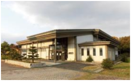
△びわ体育館（解体前）
