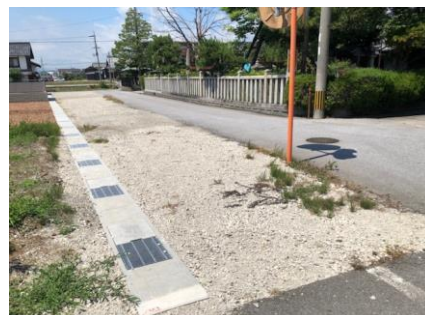
▲地福寺神照線(側溝整備)
