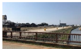
(写真) 大寺三川線道路改良工事
