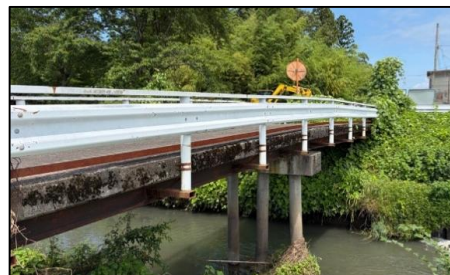
△留目地区橋梁集約撤去事業(湖北町留目)
