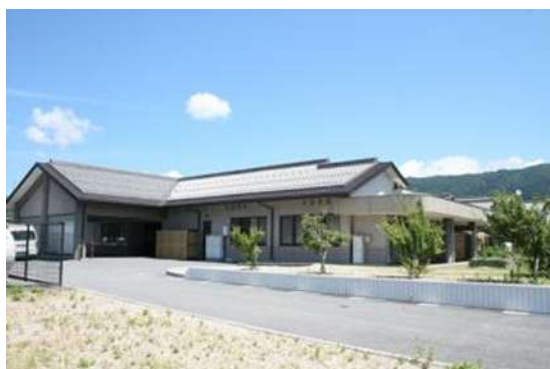
◆デイサービスセンター （リハビリデイサービス西浅井） 機械浴槽1基
