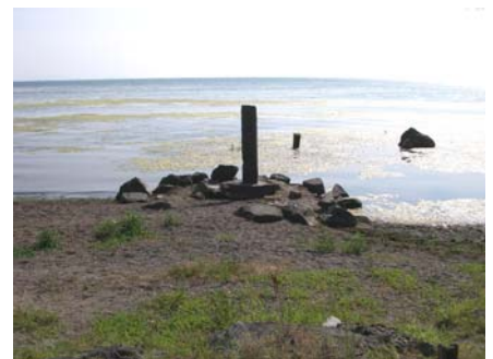
(現況写真) 洗堀が懸念される太閤井戸の保全
