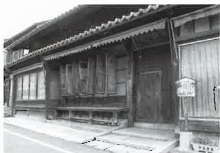
木之本宿本陣薬局 街道沿いにあるのは古い町屋だけではありません。現在、人々の交流の場・文化の発信基地として活用されている「きのもと交遊館」はかつての銀行を改修した施設です。昭和10年に新築された洋風建築で、銀行の合併などを経ながら50年にわたり使用されてきました。その後しばらくは空き家になっていましたが、北国街道の歴史を物語る資料として保存されることになりました。
