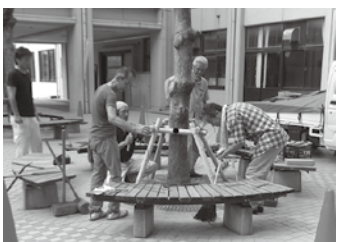
▲市内小学校での作業の様子
