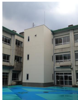
例：エレベータ設置（設置後）
