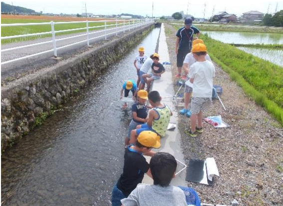
周りは石垣で囲まれ、底には石が敷き詰められています。
