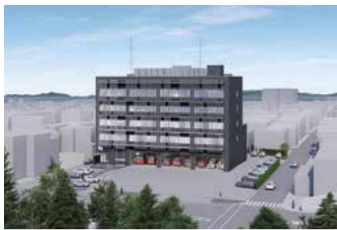
▲消防本部庁舎
