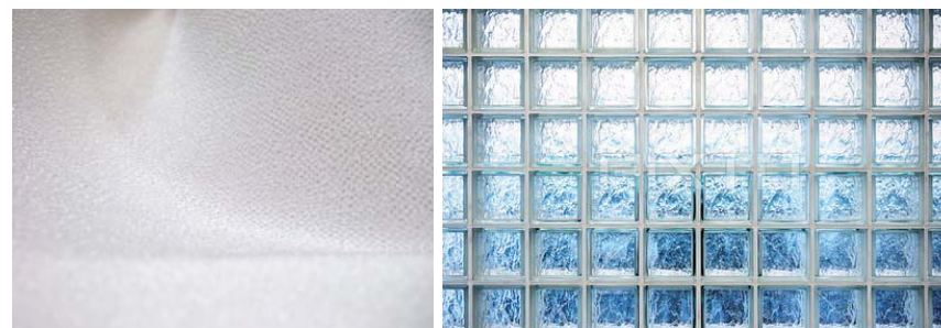
浜縮緬をイメージしたPC版やガラスブロックで構成する外壁
