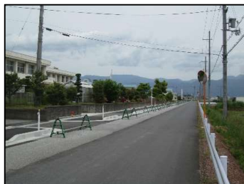
(写真) 曾根通学線道路改良工事
