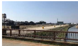
(写真)大寺三川線道路改良工事
