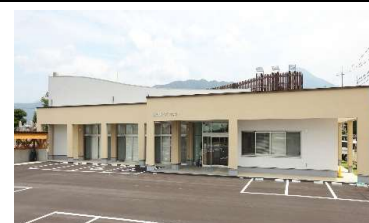
788.81㎡ ※旧施設解体、平成30年度
