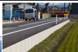
南田附東加納線 道路改良工事
