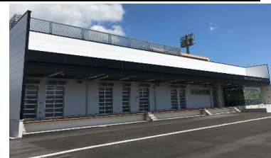
2,831.13㎡ ※旧施設解体、平成30年度
