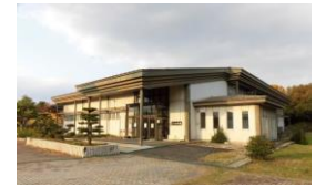
△びわ体育館（解体前）
