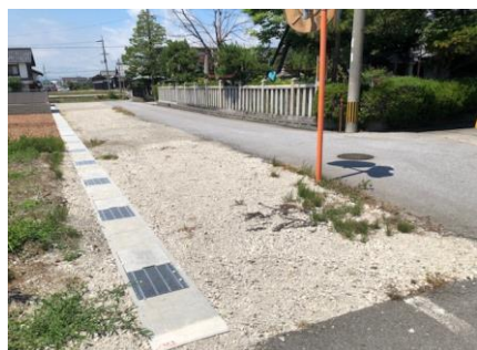
▲地福寺神照線(側溝整備)
