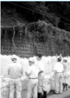
崩落現場（鍛冶屋） の現地視察
