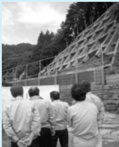
西浅井町月出地区急傾斜地崩落現場を現地視察
