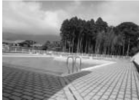
富永小学校プール
