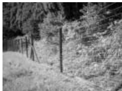
獣害対策防護柵 (西浅井町中)
