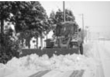
市職員による除雪作業
