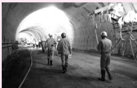
新観音坂トンネル工事現場
