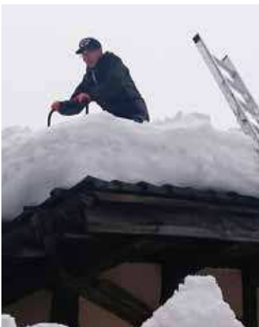
屋根の雪下ろし
