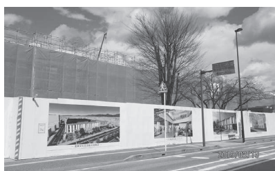
工事中のながはま文化福祉プラザ
