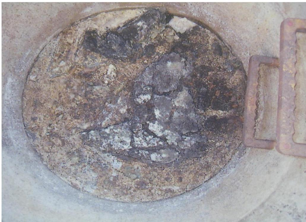
〔油が固まり閉塞した下水道本管〕
