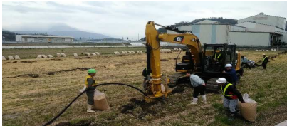
※地下水位制御システム（FOFAS）を施工（北：H30.4月、南：H31.4月）
