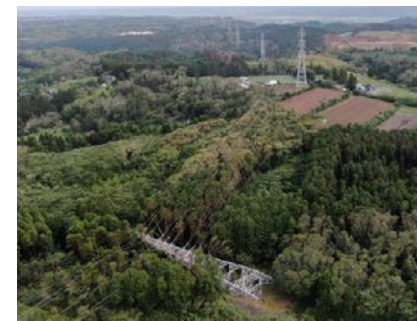
鉄塔設備の倒壊（君津市）
