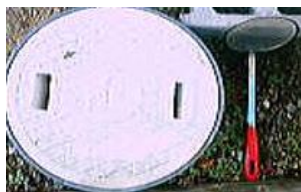
"Kurin Masu" cavidad de drenaje de la cocina
