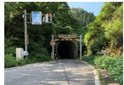
柳ヶ瀬トンネル
