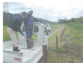
周辺環境の整備 (不法投棄防止柵の設置)
