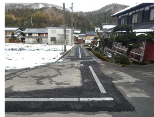
消雪管布設(実施中)
