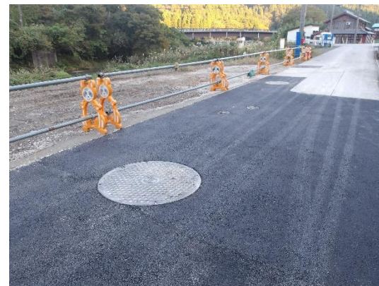
集水井整備(完成)
