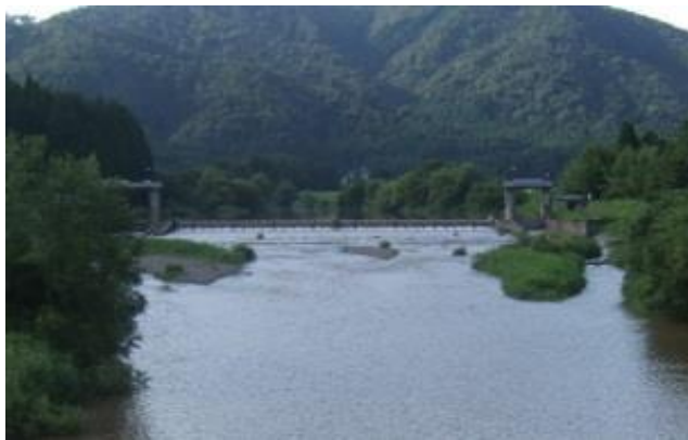
高時川頭首工付近
