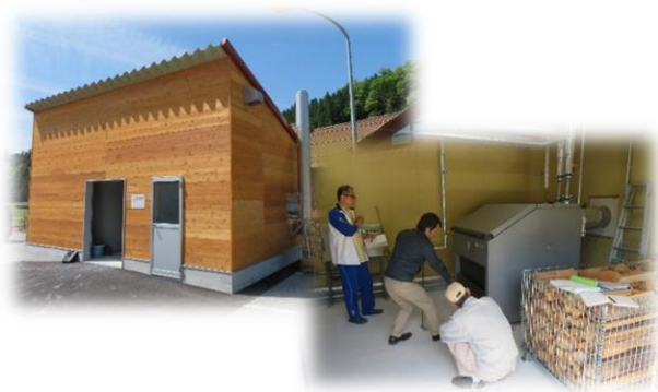
健康パークあざいの薪ボイラー（野瀬町）
