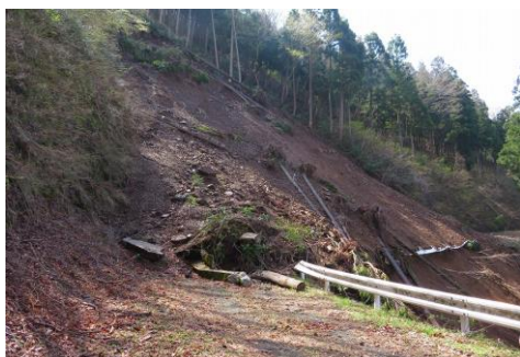
山腹崩壊の状況
