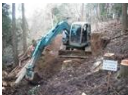
森林作業道開設作業の現場
