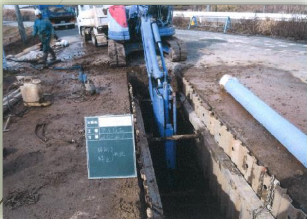
污水管敷設（開削工）
