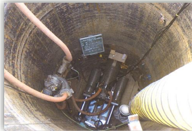
污水管敷設（推進工）
