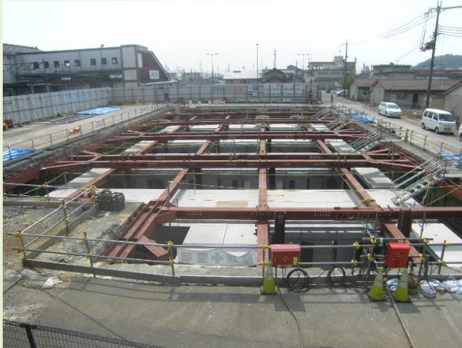
赤川排水区雨水貯留槽築造
