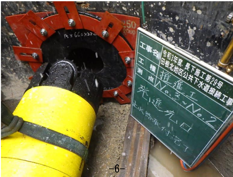
⑤発進坑口工（止水器取付）
