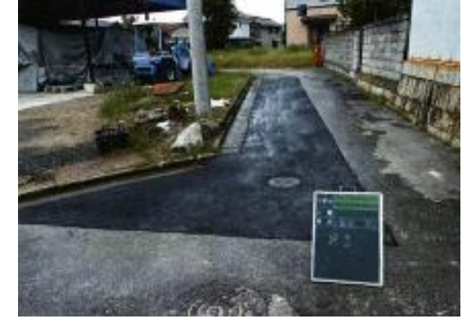
写真：工事の様子
