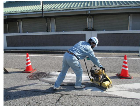
写真：直営陥没修繕
