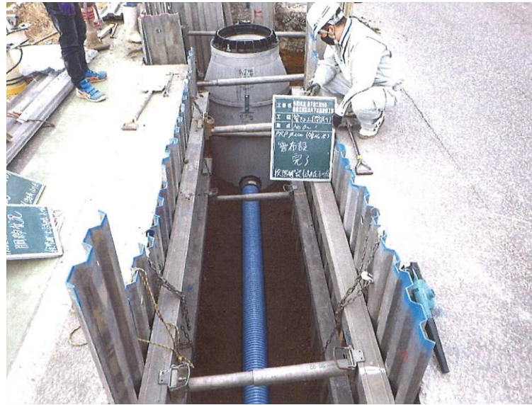
⑤下水道管布設
