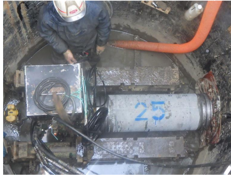
⑧推進管据付・推進
