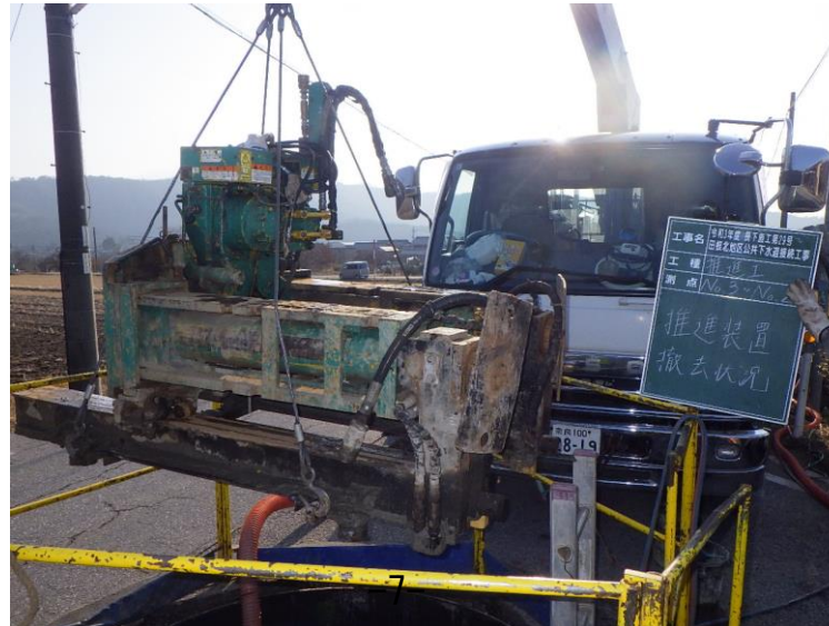
⑪推進装置撤去
