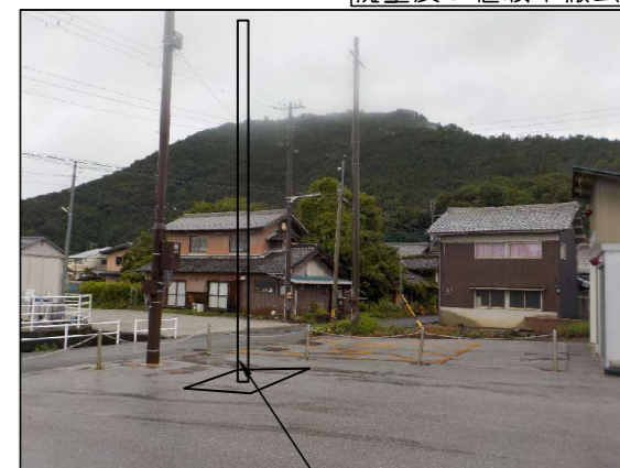
ホース乾燥柱新設
