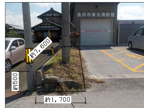
擁壁及び植栽帯撤去処分
