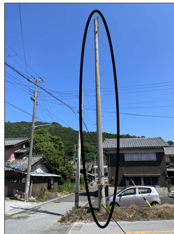
既存ホース乾燥柱
