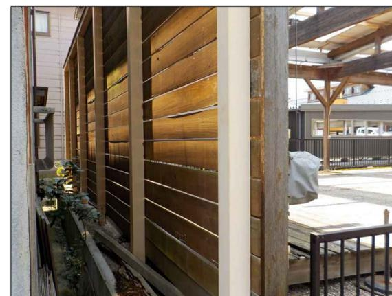
⑤目隠しホルダー外部（ホルダー及び間柱撤去の上モルタル補修6箇所）
