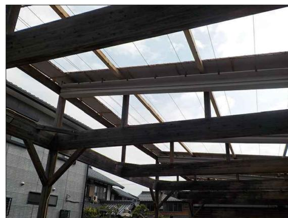
③屋根部（鉄骨フレーム及び開閉シート撤去）
