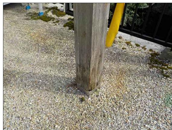
②柱脚部（柱脚金物撤去の上モルタル補修8箇所）
