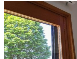
熱伝導率の低い木製サッシ・Low-Eペアガラスで断熱
