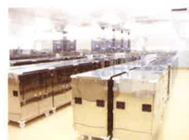
⑨コンテナプール
