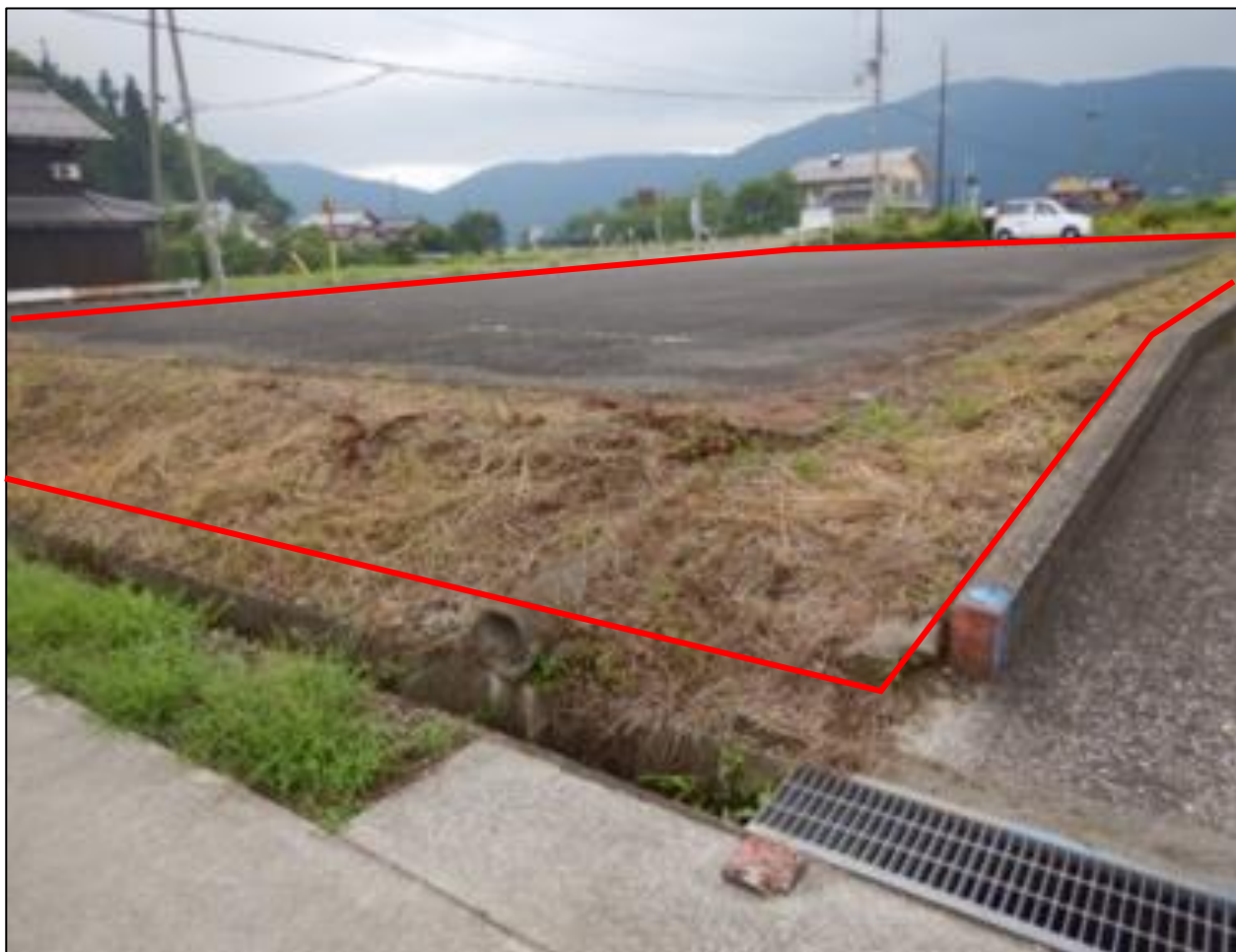
物件北東から撮影
