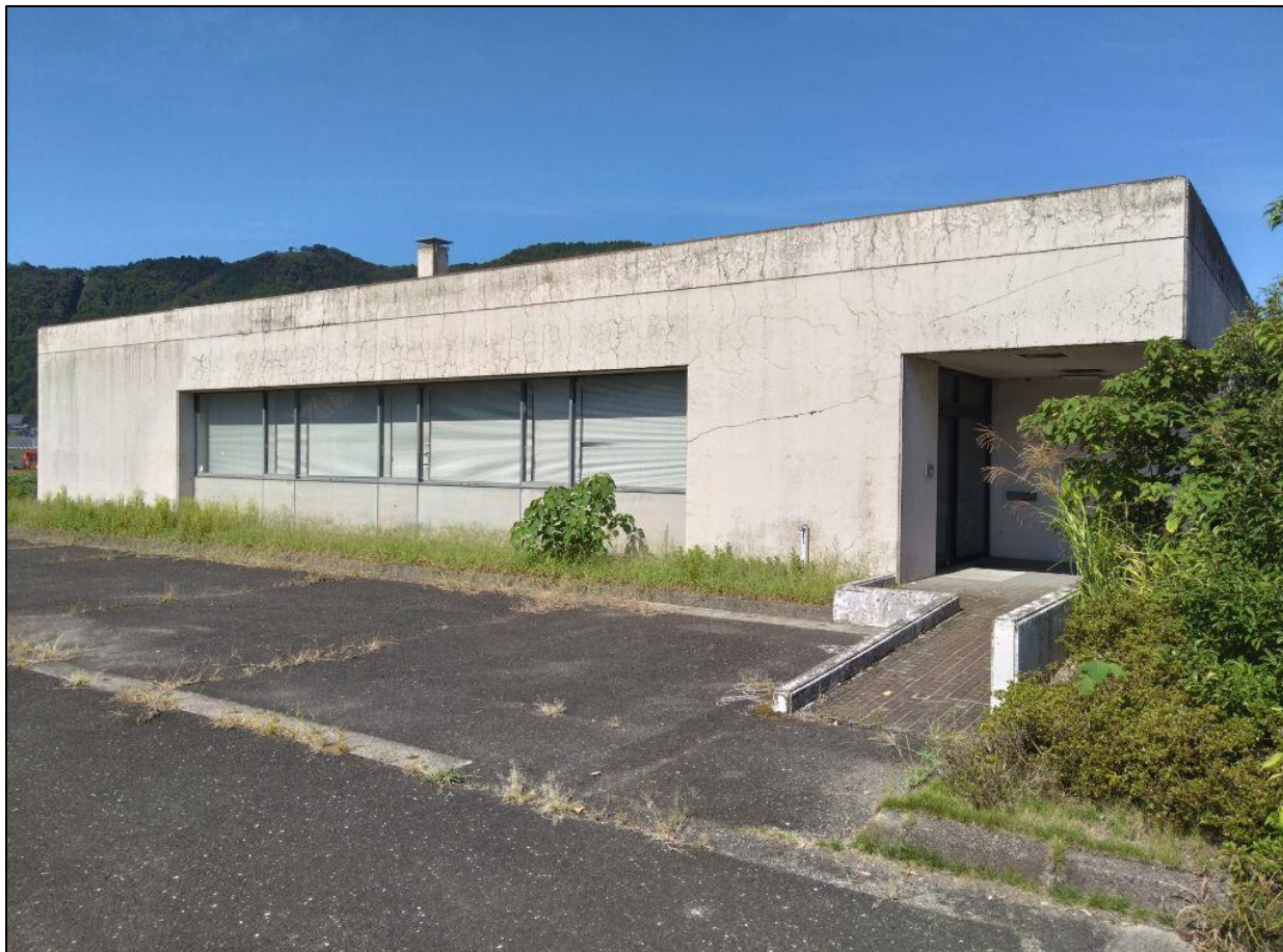
物件南側から撮影
