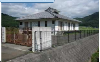
山田小山処理場
