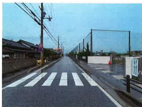
前面道路( 進入口 ) 1
